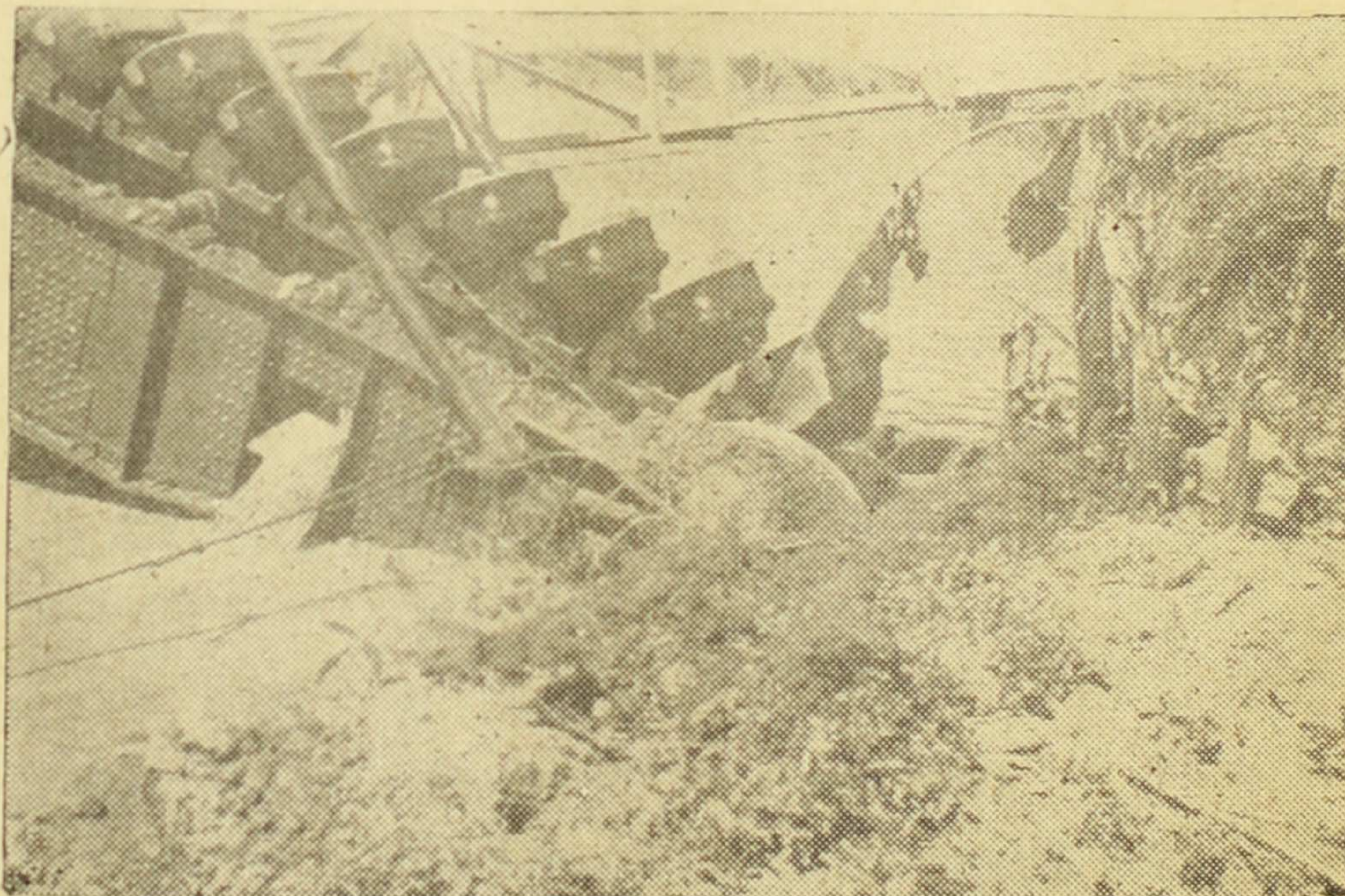
Cucharas excavadoras de la draga, trabajando.
